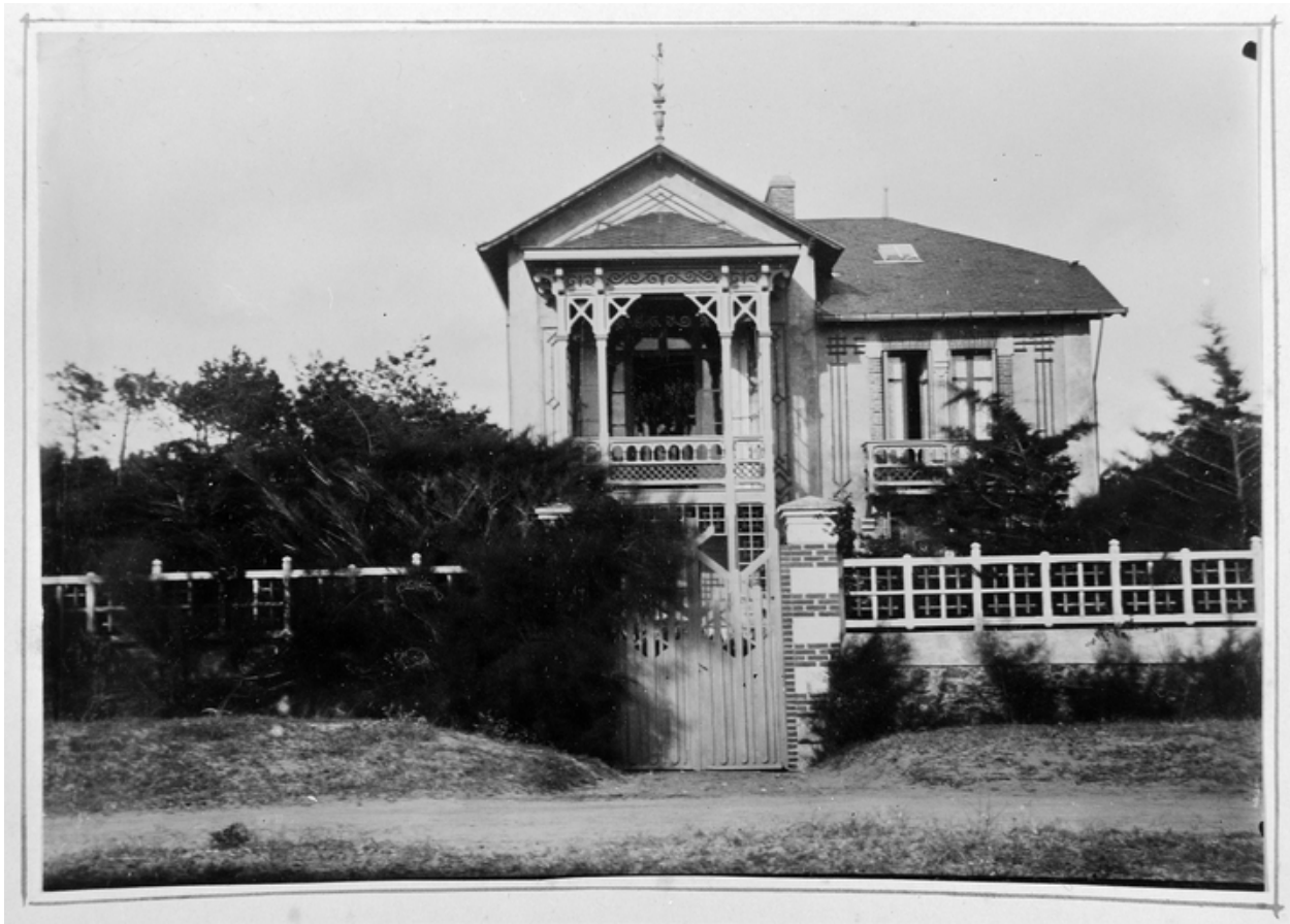
Elévation antérieure. Photographie ancienne.
