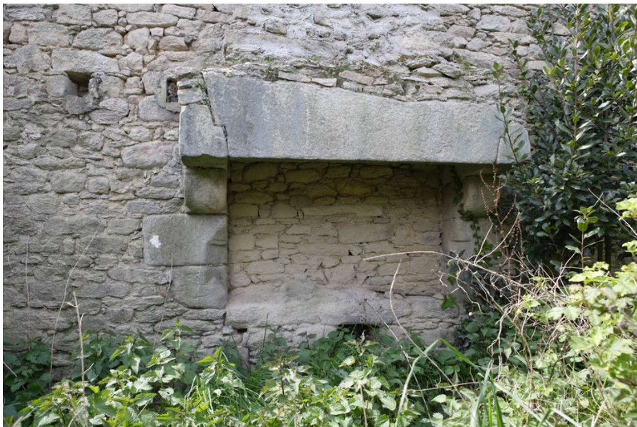
Détail de la cheminée du premier logis.
