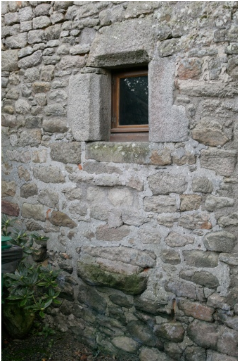
Détail de la fenêtre d'évier.
