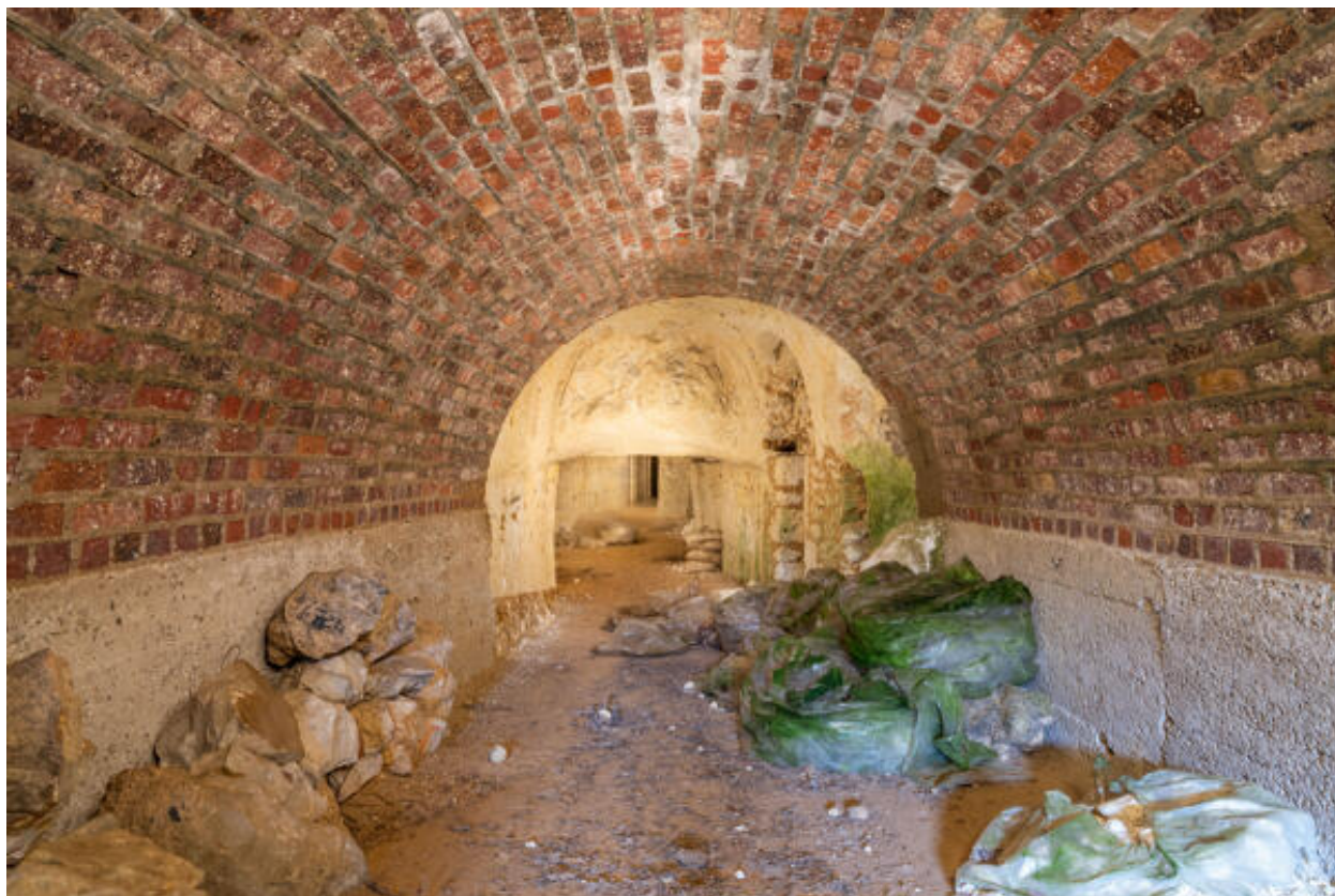
Vue au niveau de l'entrée.
