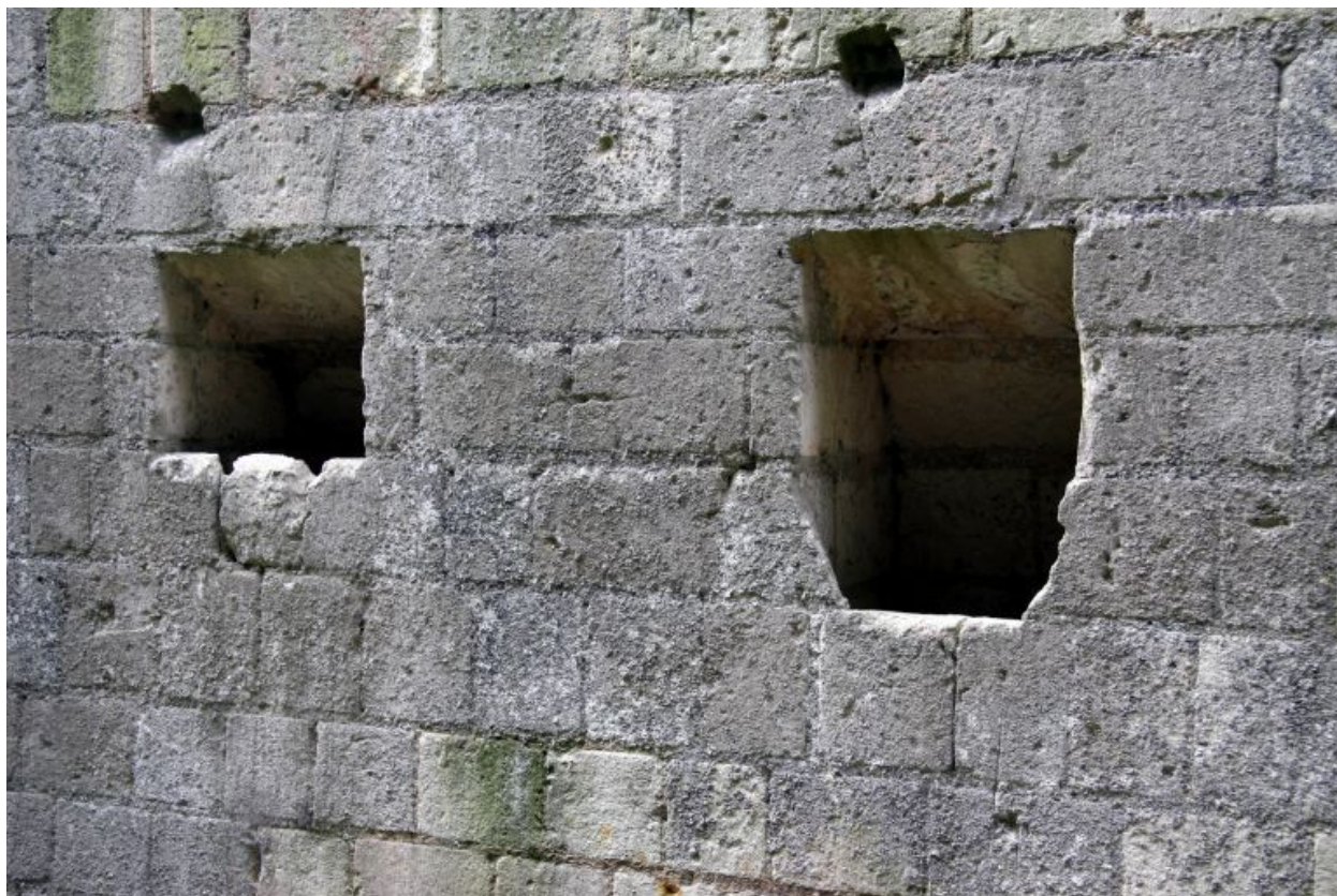
Ancien château, tour de défense : façade postérieure.
