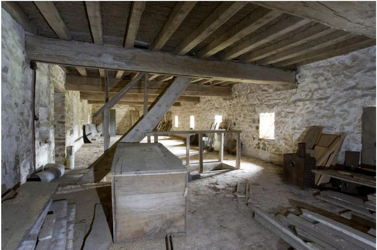
Ecurie-grange : vue d'ensemble du premier étage.
