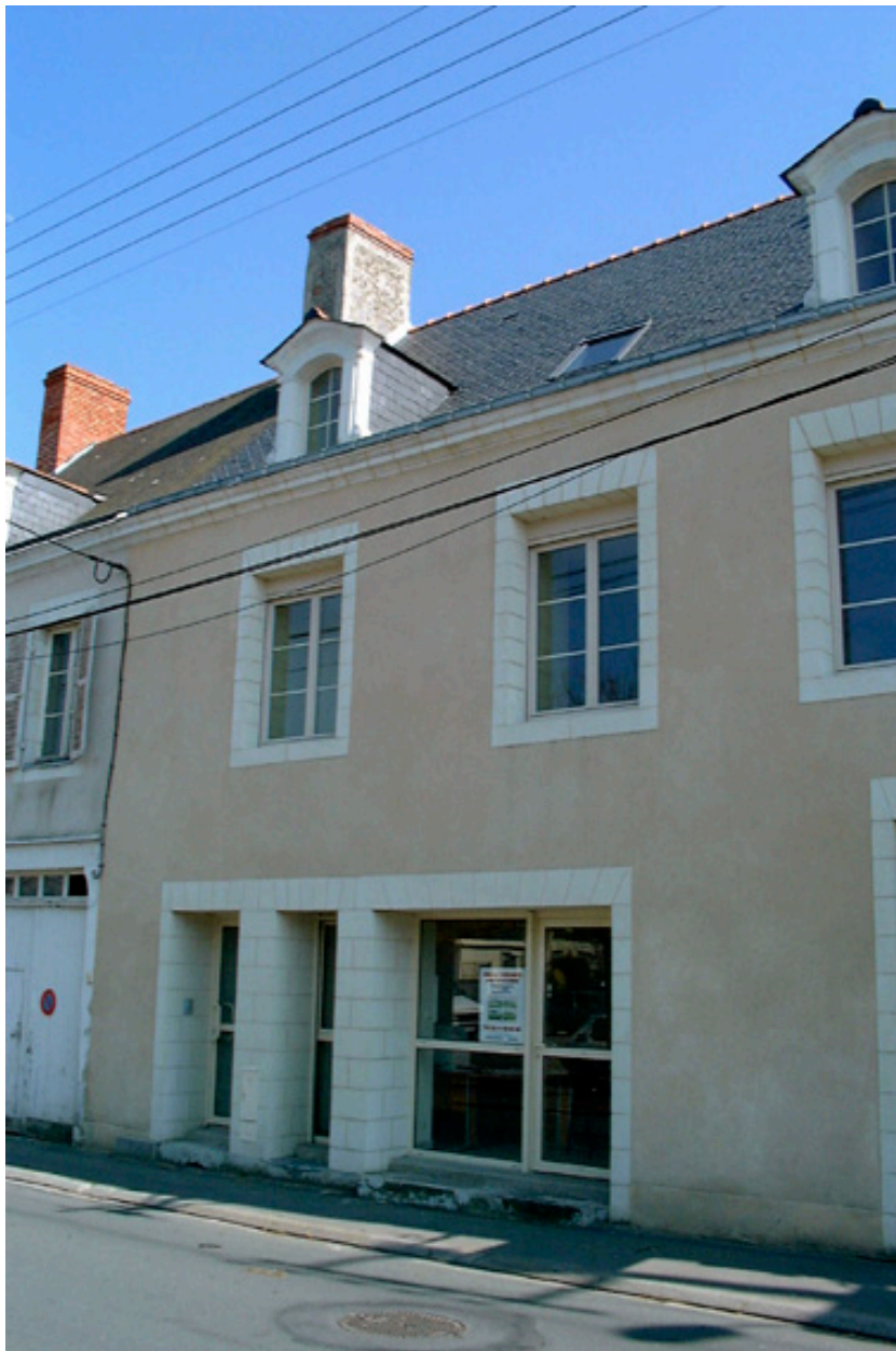
Maison. 18e siècle. Remaniée 19e siècle.
