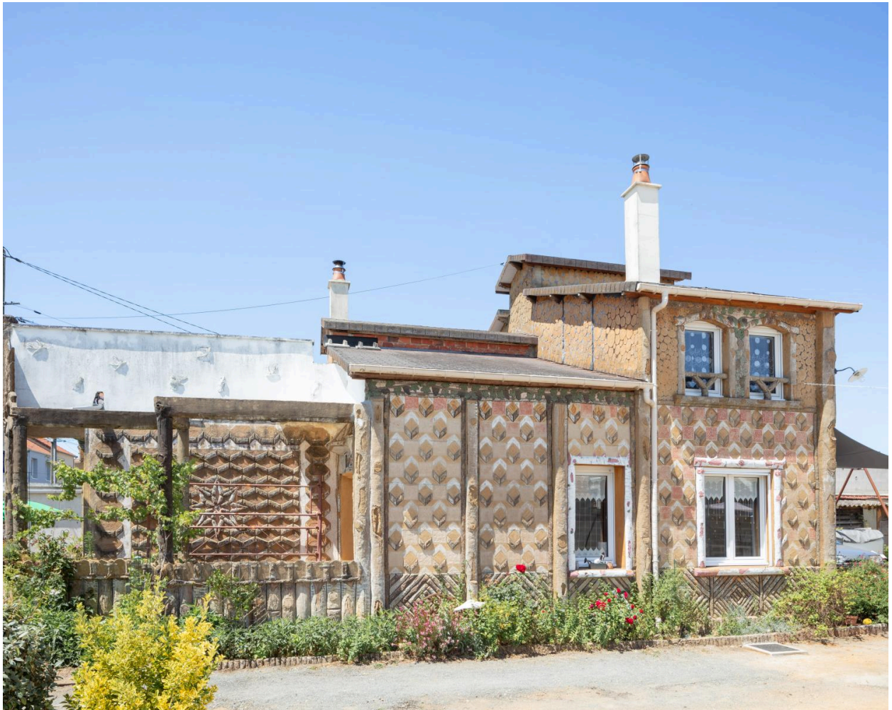
Vue de la façade sud depuis le sud.
