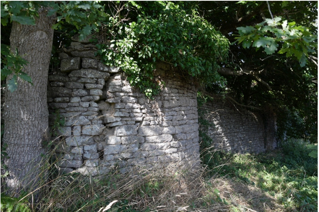
Détail de la tour de flanquement du mur de clôture.
