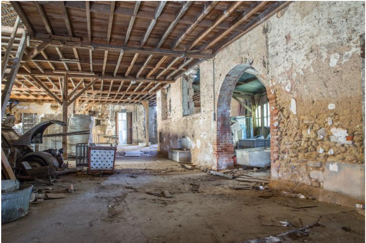
Une vue du rez-de-chaussée de l'usine.
