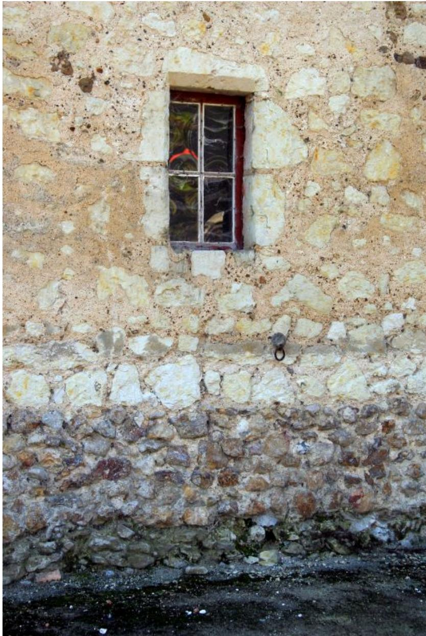
Bâtiment des greniers, détail : la mise en oeuvre des matériaux met en évidence un soubassement de rognons de silex sous une bande de moellons de tuffeau.
