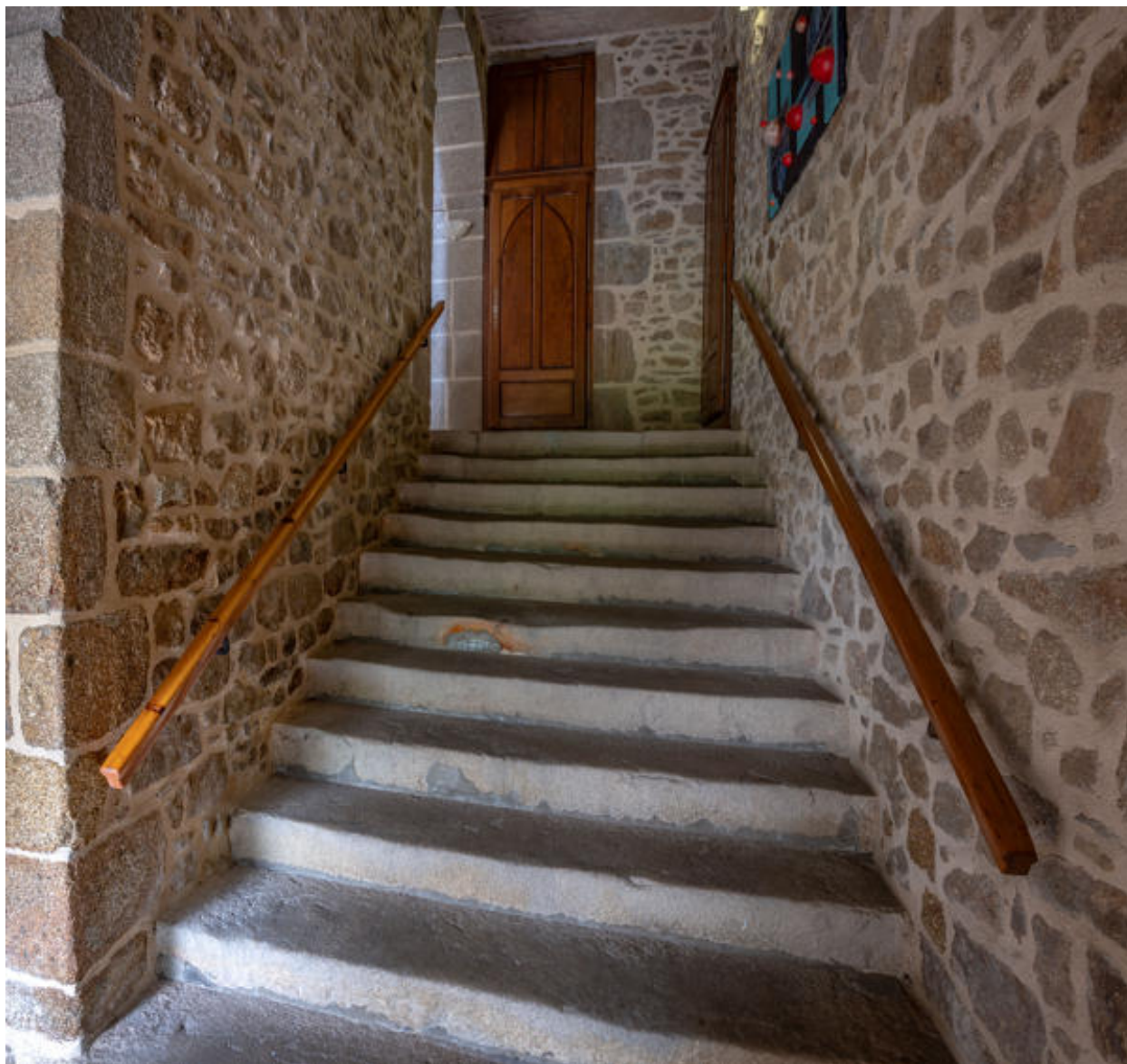
L'escalier du château.
