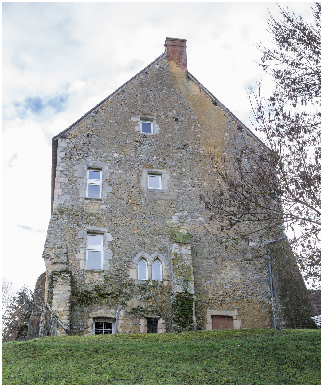
Le pignon nord-ouest.
