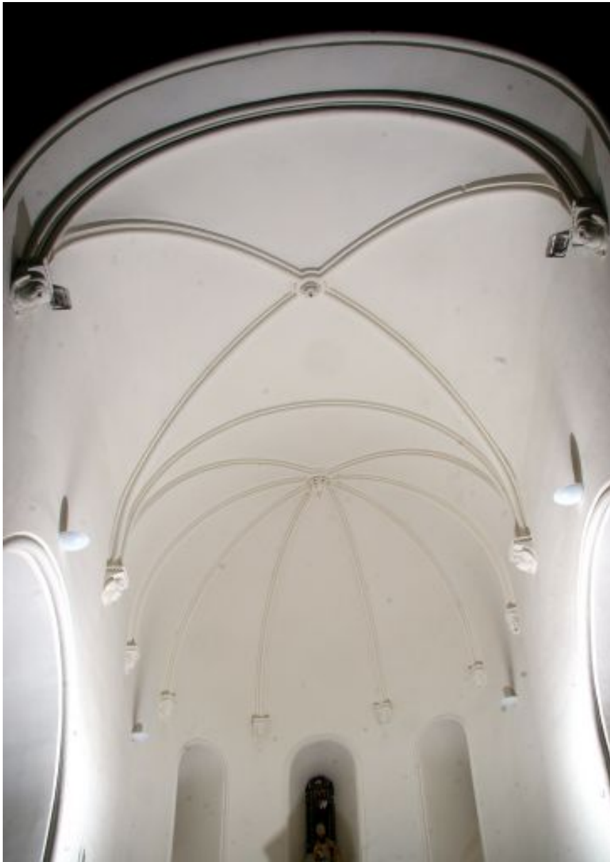
Ogives sur une voûte en berceau.
