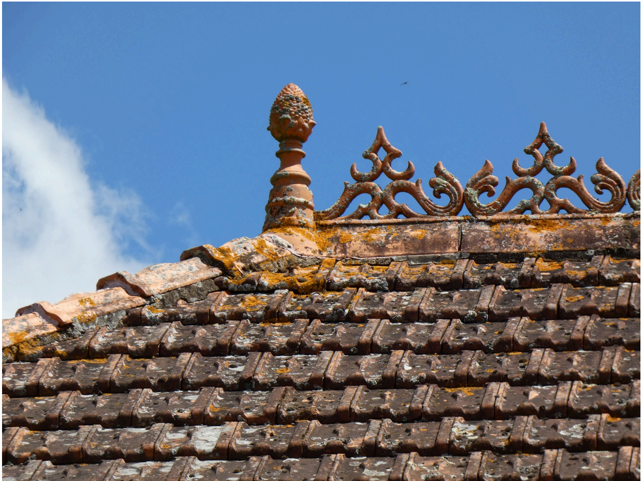
Détail du toit du corps principal du logis : épi et crête de faîtage.
