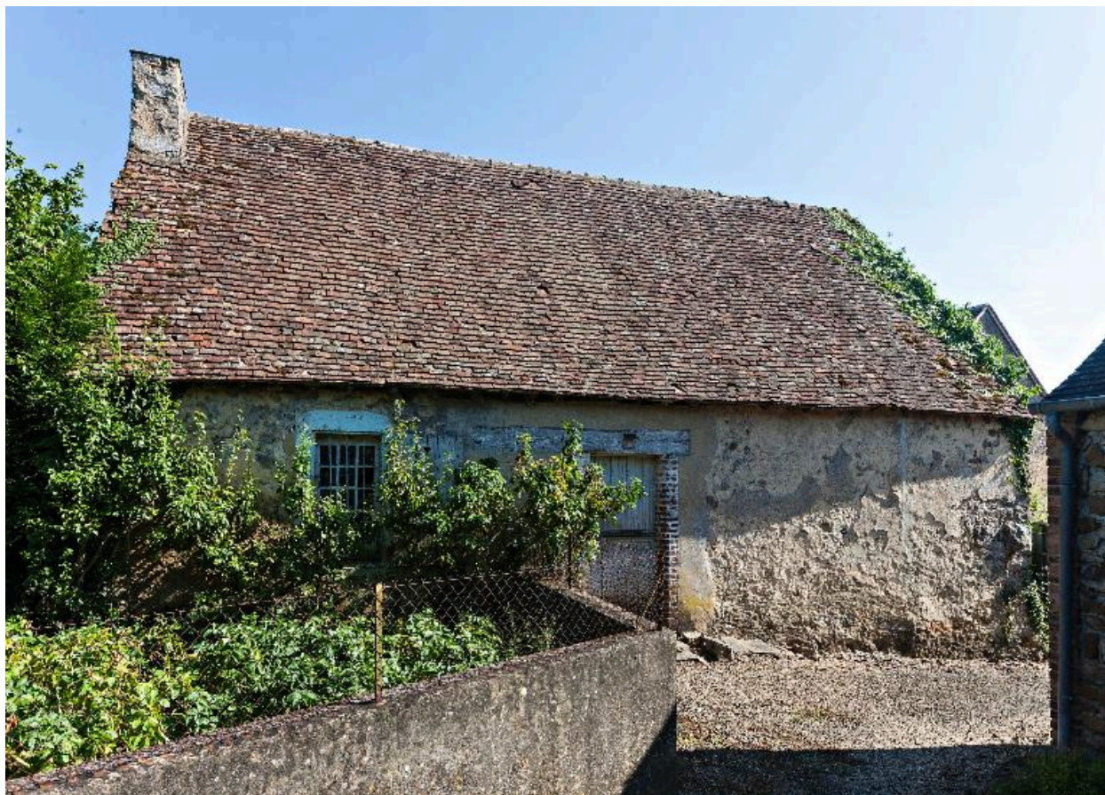
Elévation du logis sur la ruelle du Patis.
