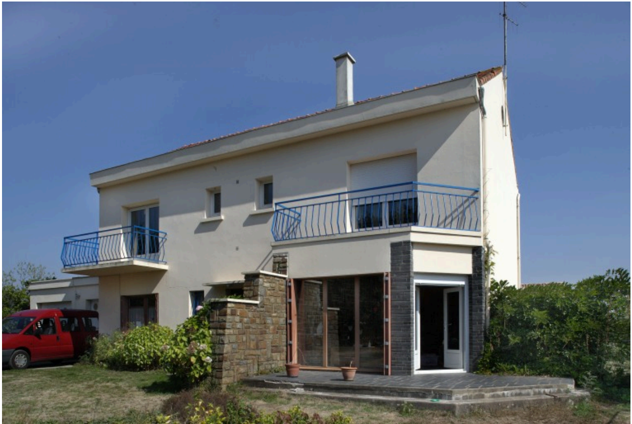
La façade antérieure de la maison n° 4 allée des Gabarres.
