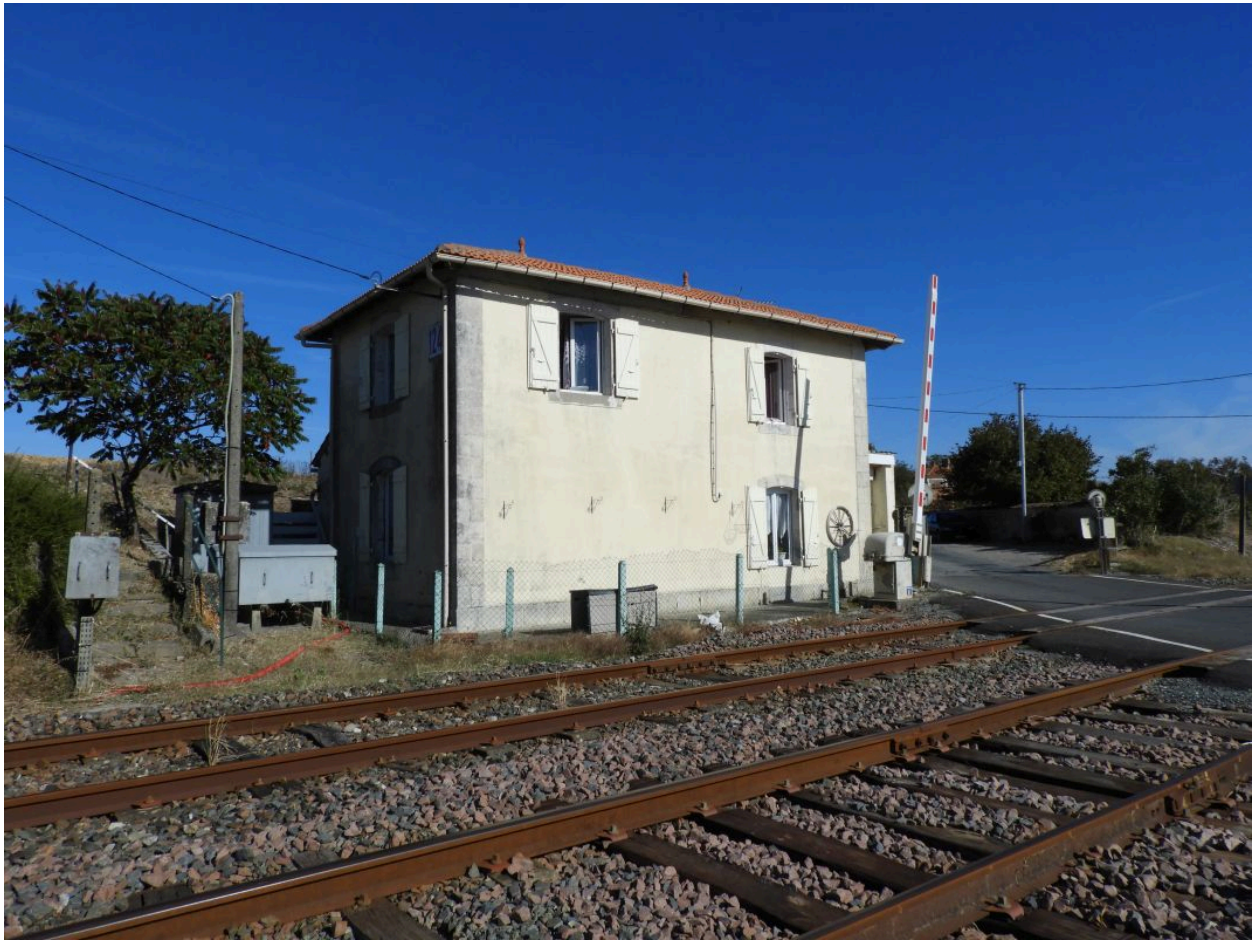
La maison de gare-barrière vue depuis le sud.
