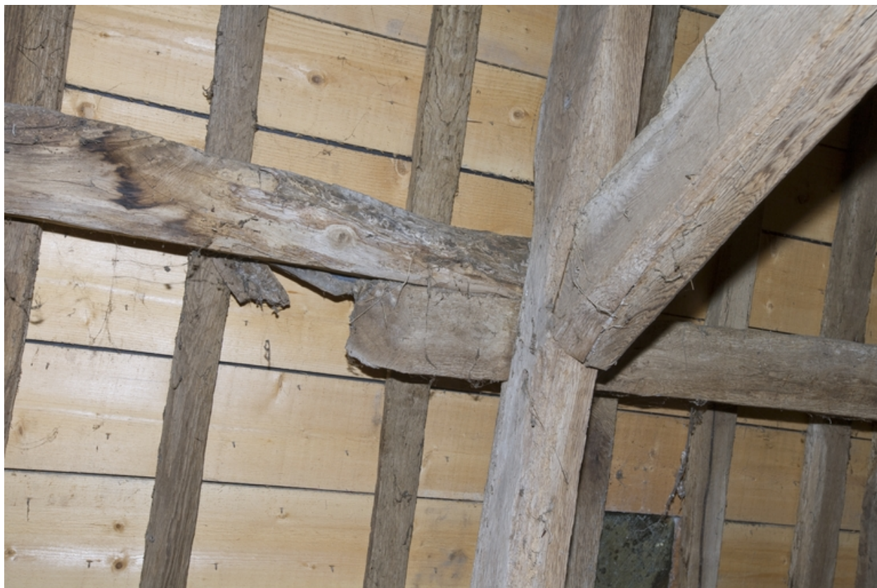
N° 10 rue Basse. Charpente. Assemblage des pannes.
