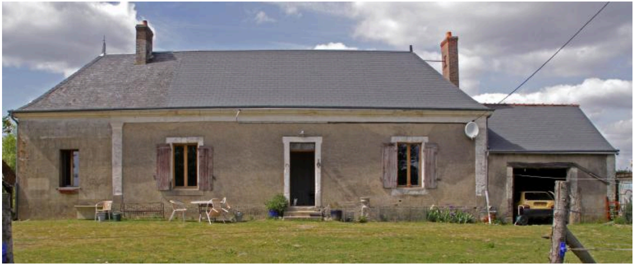
Maison : façade antérieure sur cour.
