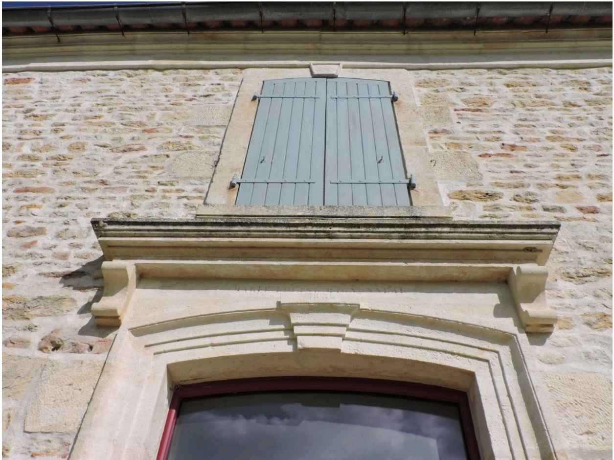
Détail de la façade du logis : décor des baies, corniche et inscription au-dessus de la porte.
