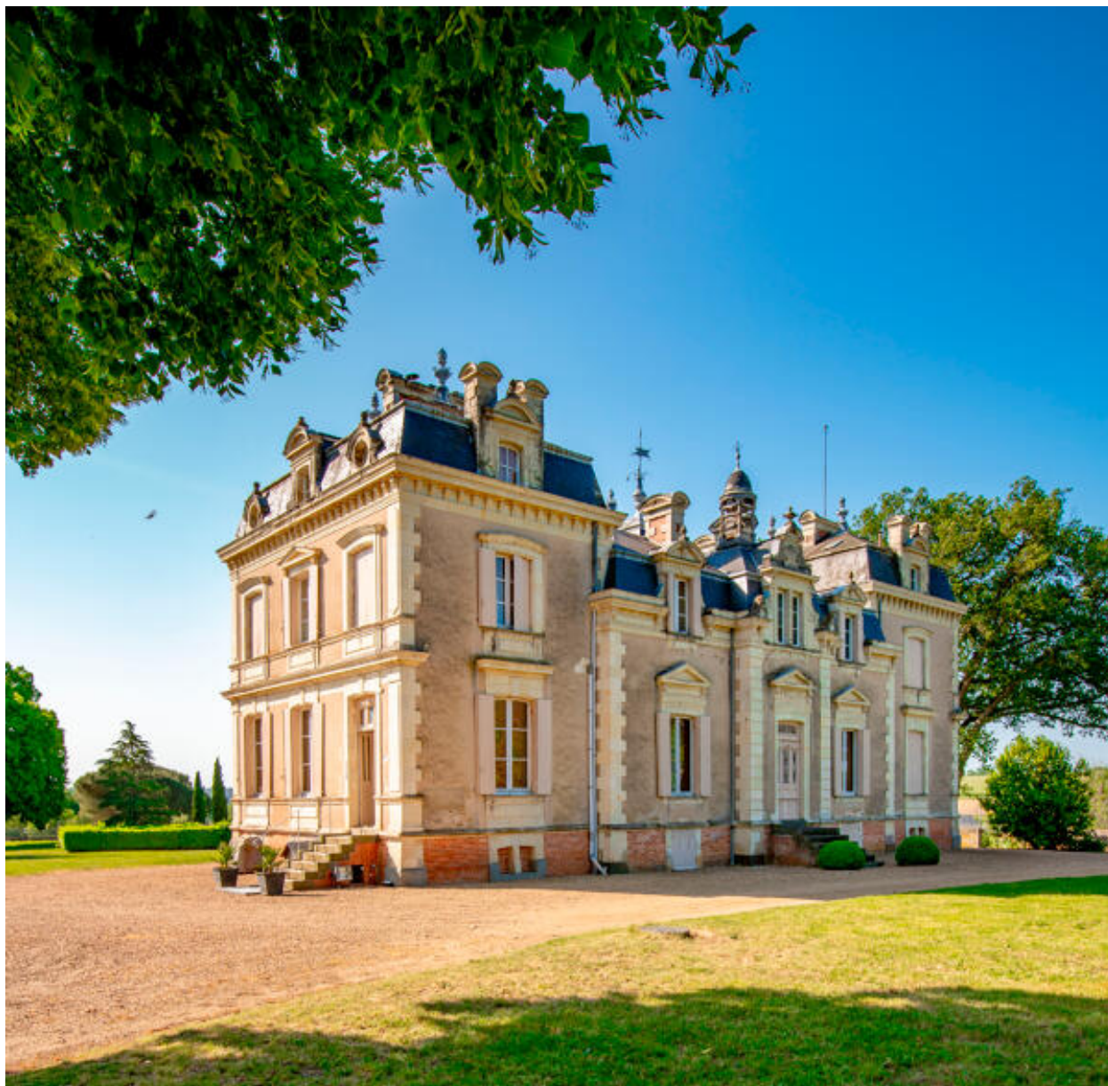
L'élévation postérieure, côté nord-ouest.
