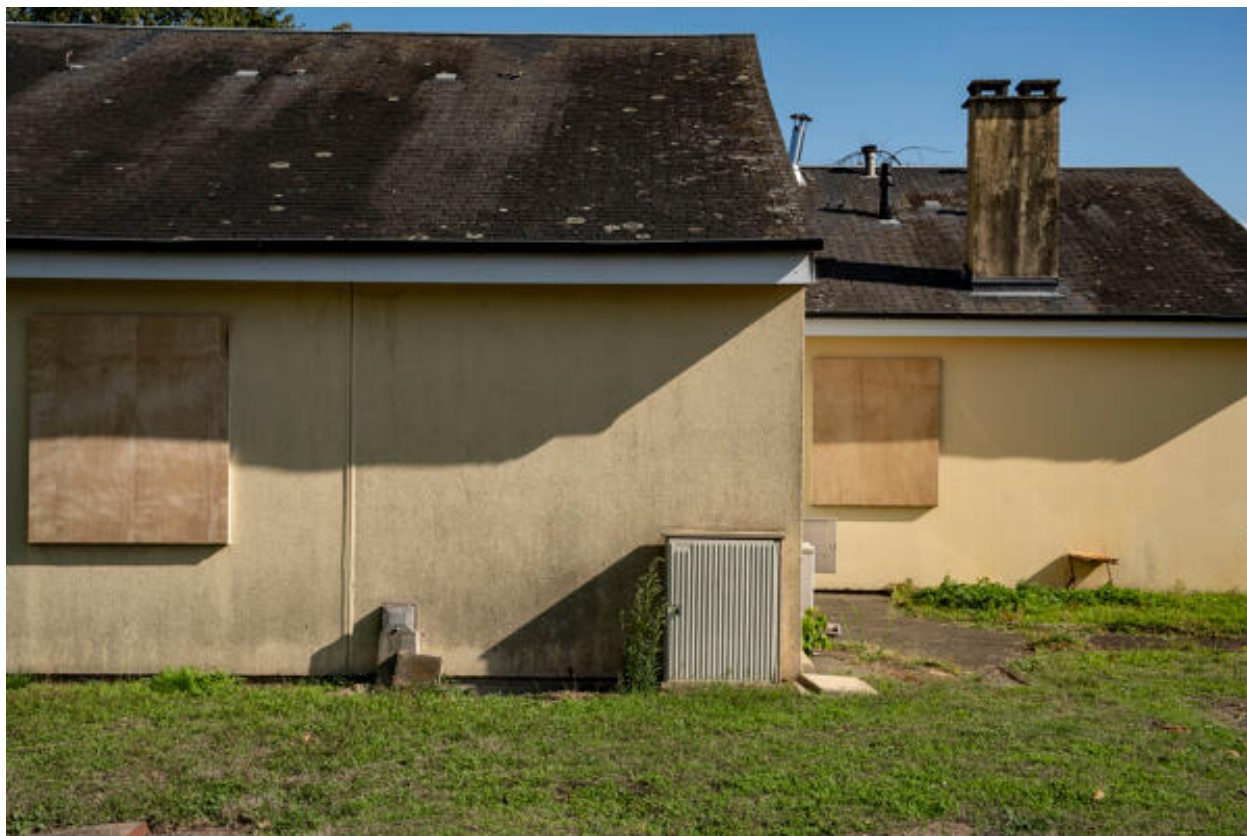
Vue de maisons rue des bouleaux.
