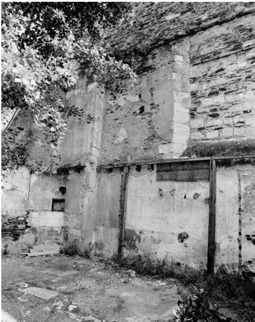
Vestige de l'église. Première chapelle sud-ouest dite de Beauvau, élévation extérieure sud : détail sur le contrefort et l'ébrasement gauche (ouest) de la baie. Prise de vue effectuée depuis la cour de la maison 44 rue Lionnaise.
