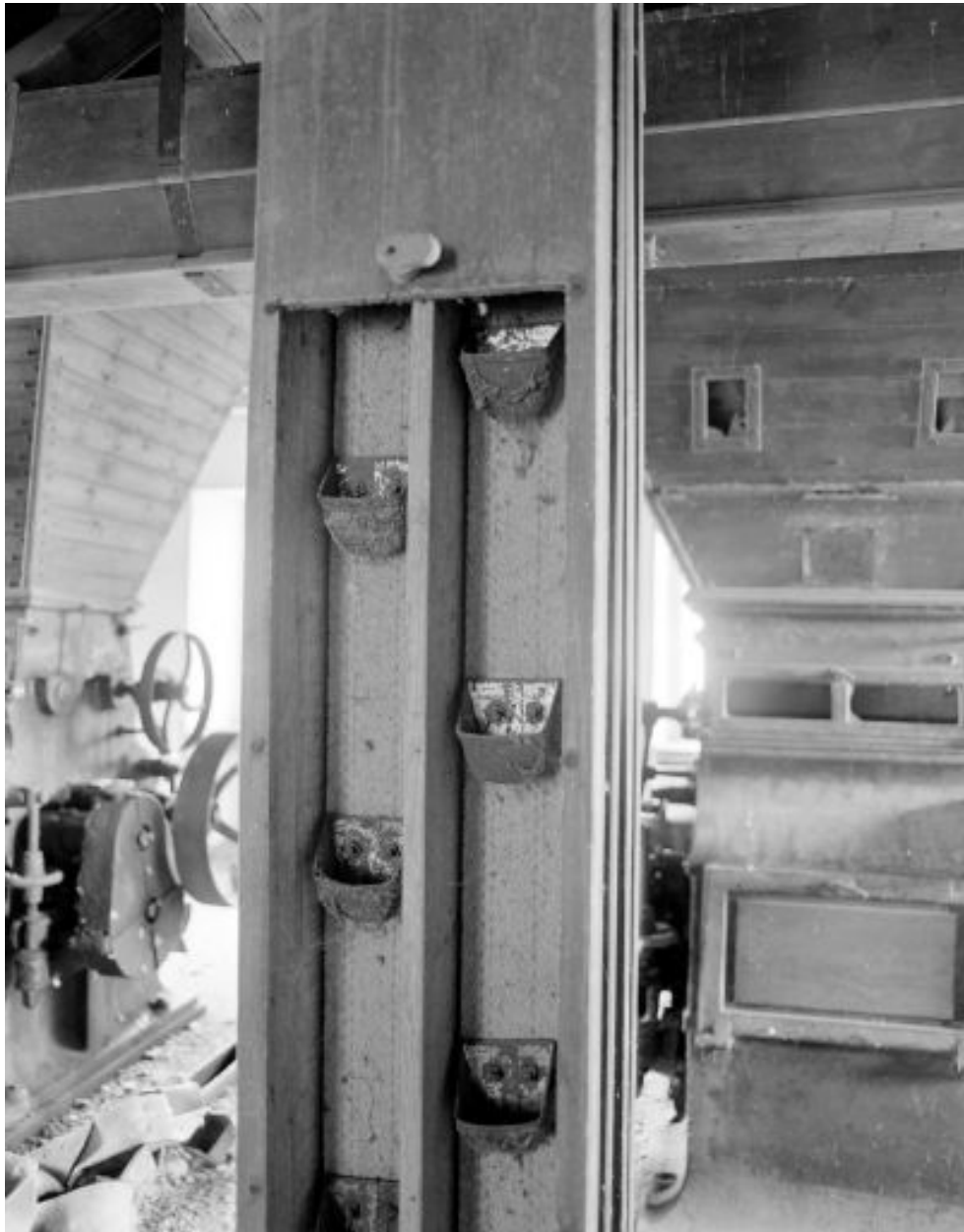
Premier étage, en 2002 : élévateur à godets.
