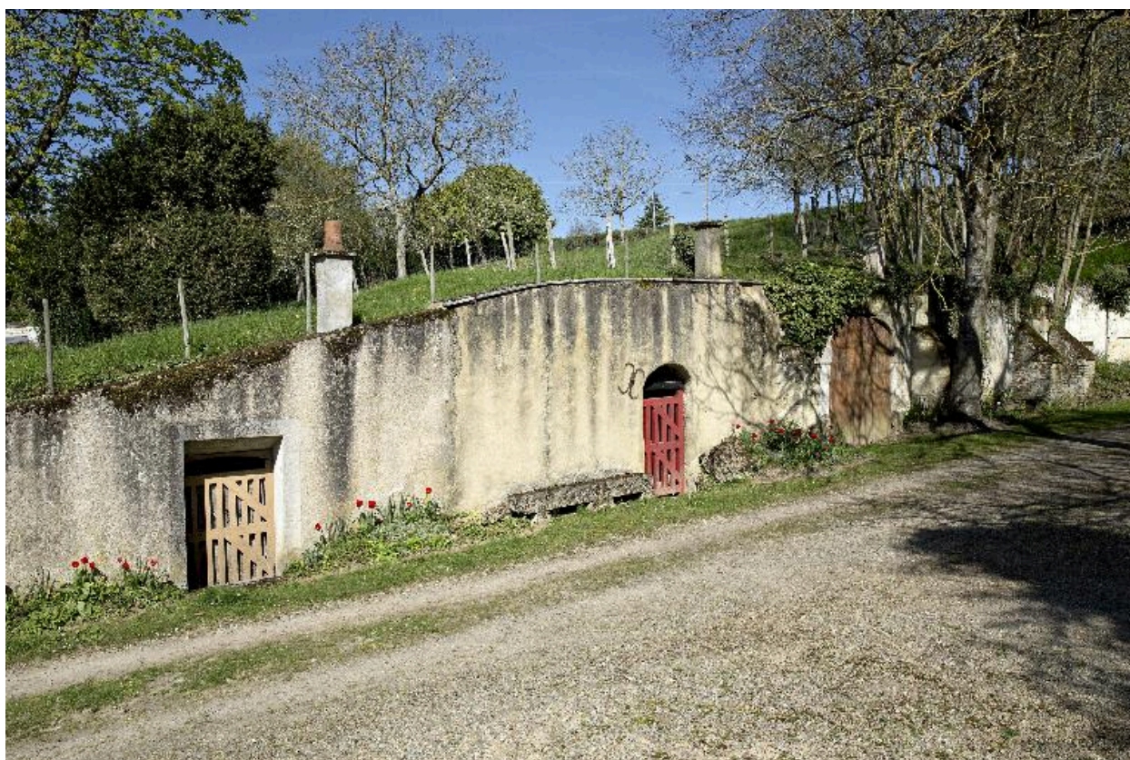
Cavier de Saint-Amadou, Ruillé-sur-Loir : face ouest, caves dotées de cheminées.
