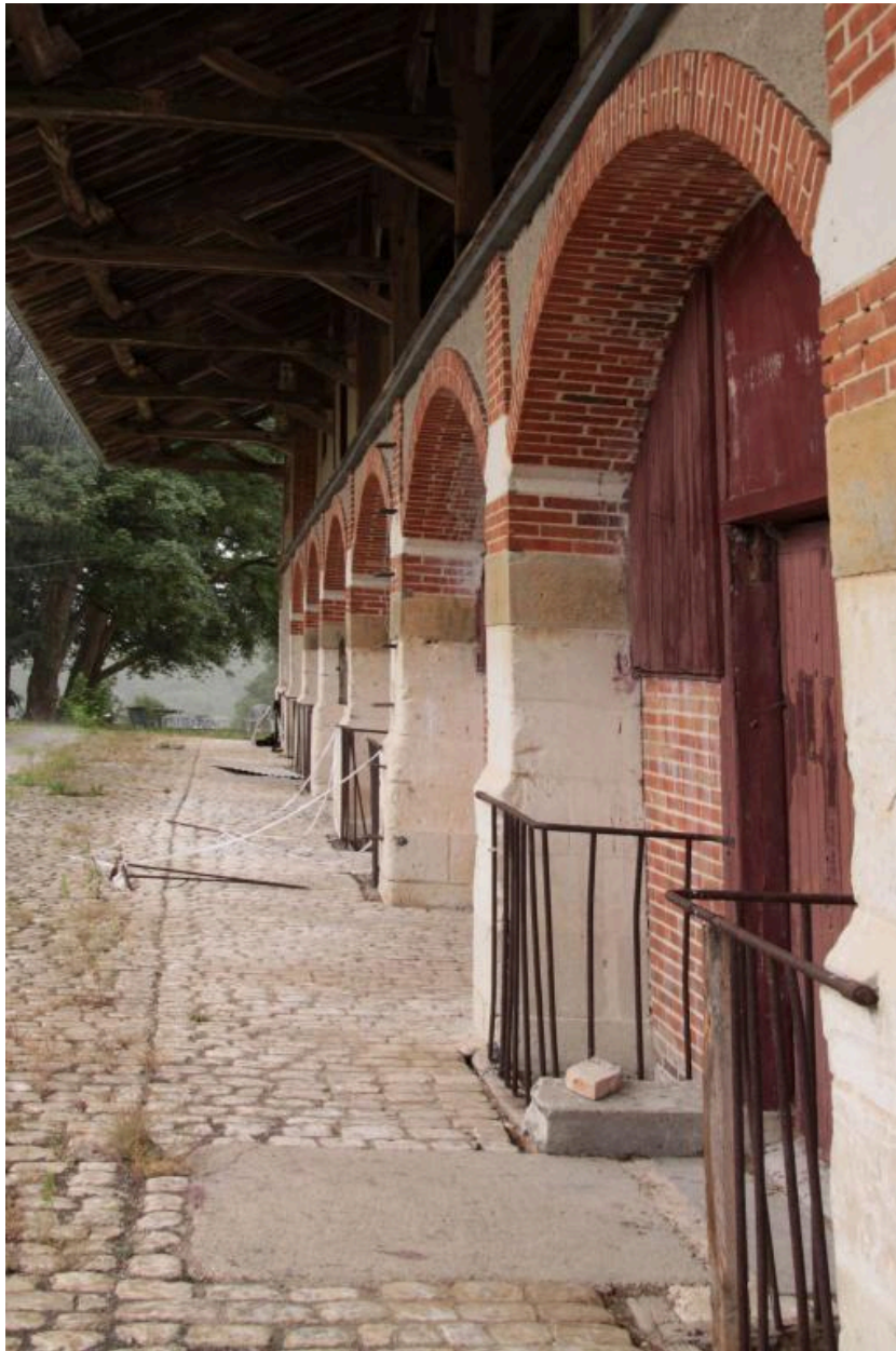
Vacherie : étables sur la façade ouest.
