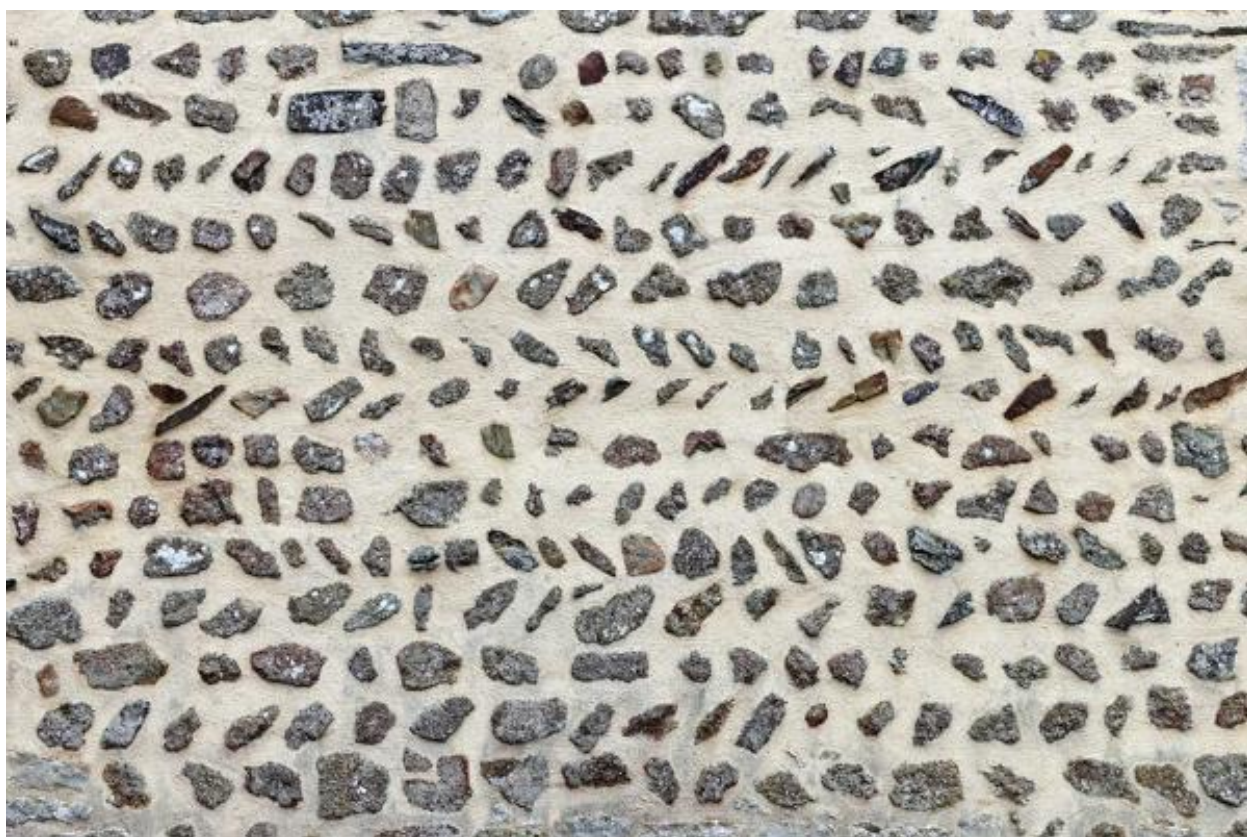
Maçonnerie en opus spicatum du bas-côté sud.
