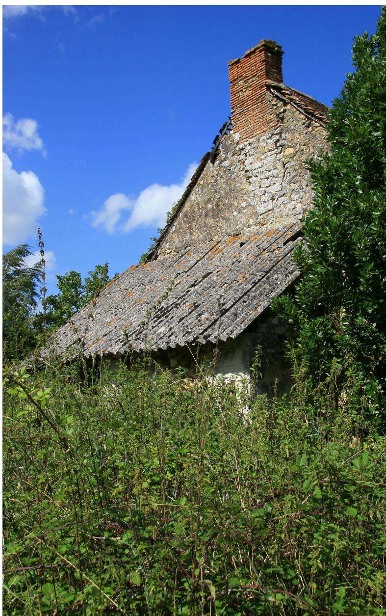
La maison du XVII e siècle : pignon avec four à pain couvert d'un appentis.
