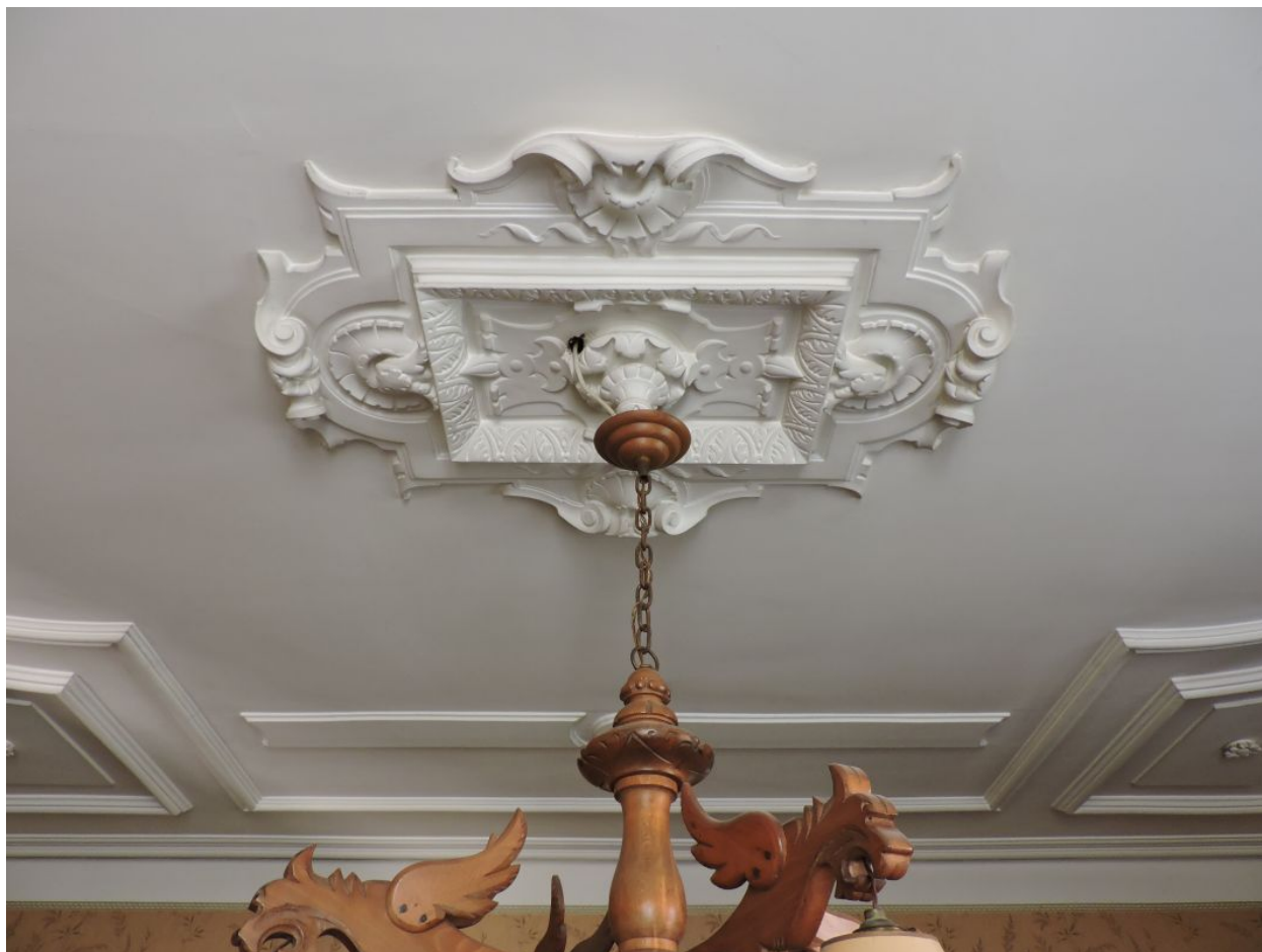
Exemple de décor mouluré au rez-de-chaussée.
