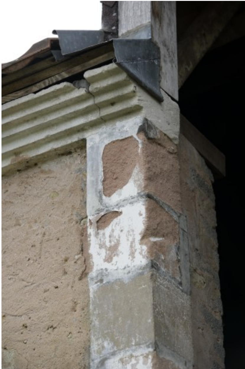
Étables, élévation antérieure : détail du piedroit d'une porte haute.
