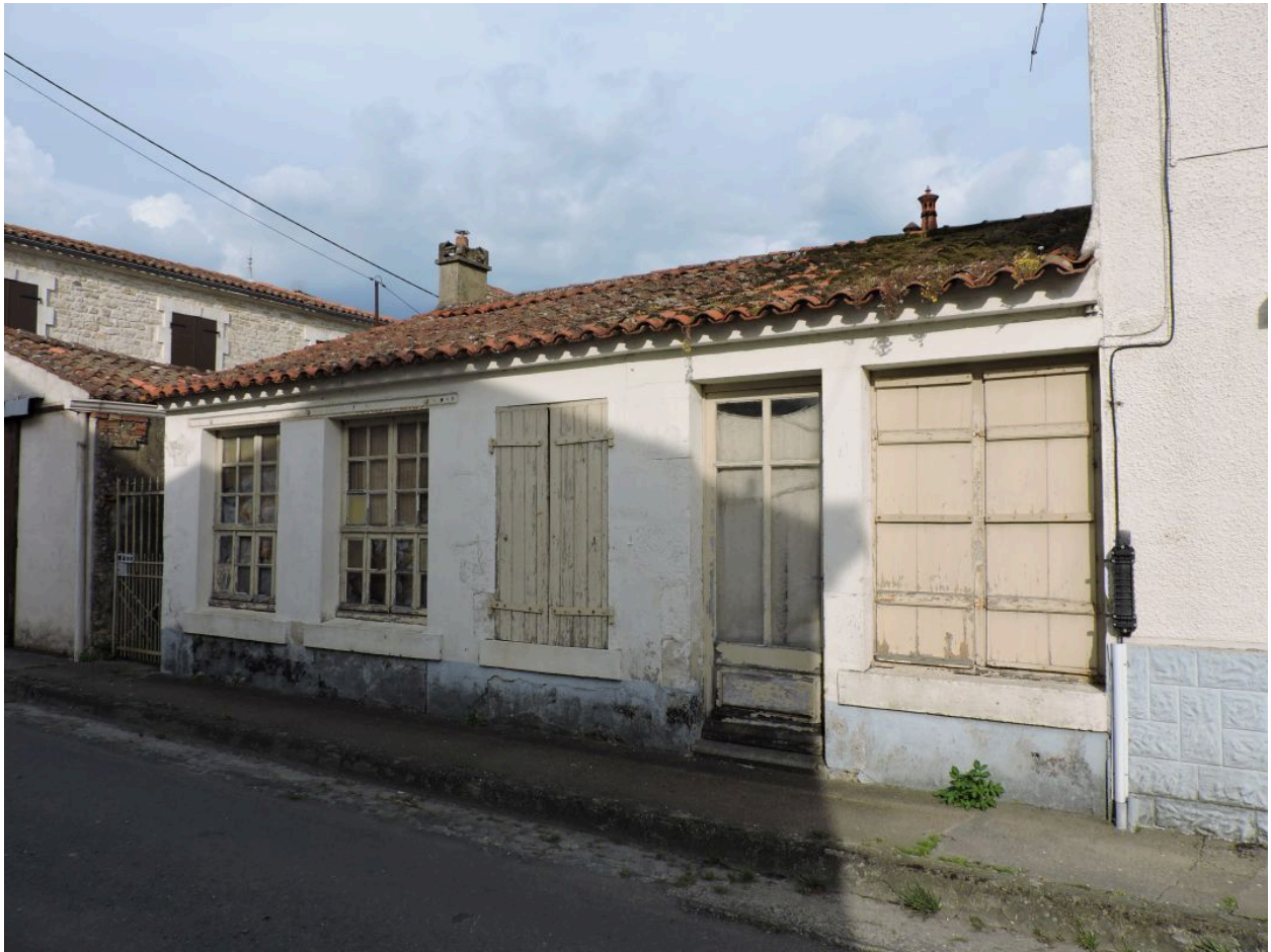
L'ancien atelier vu depuis l'ouest.
