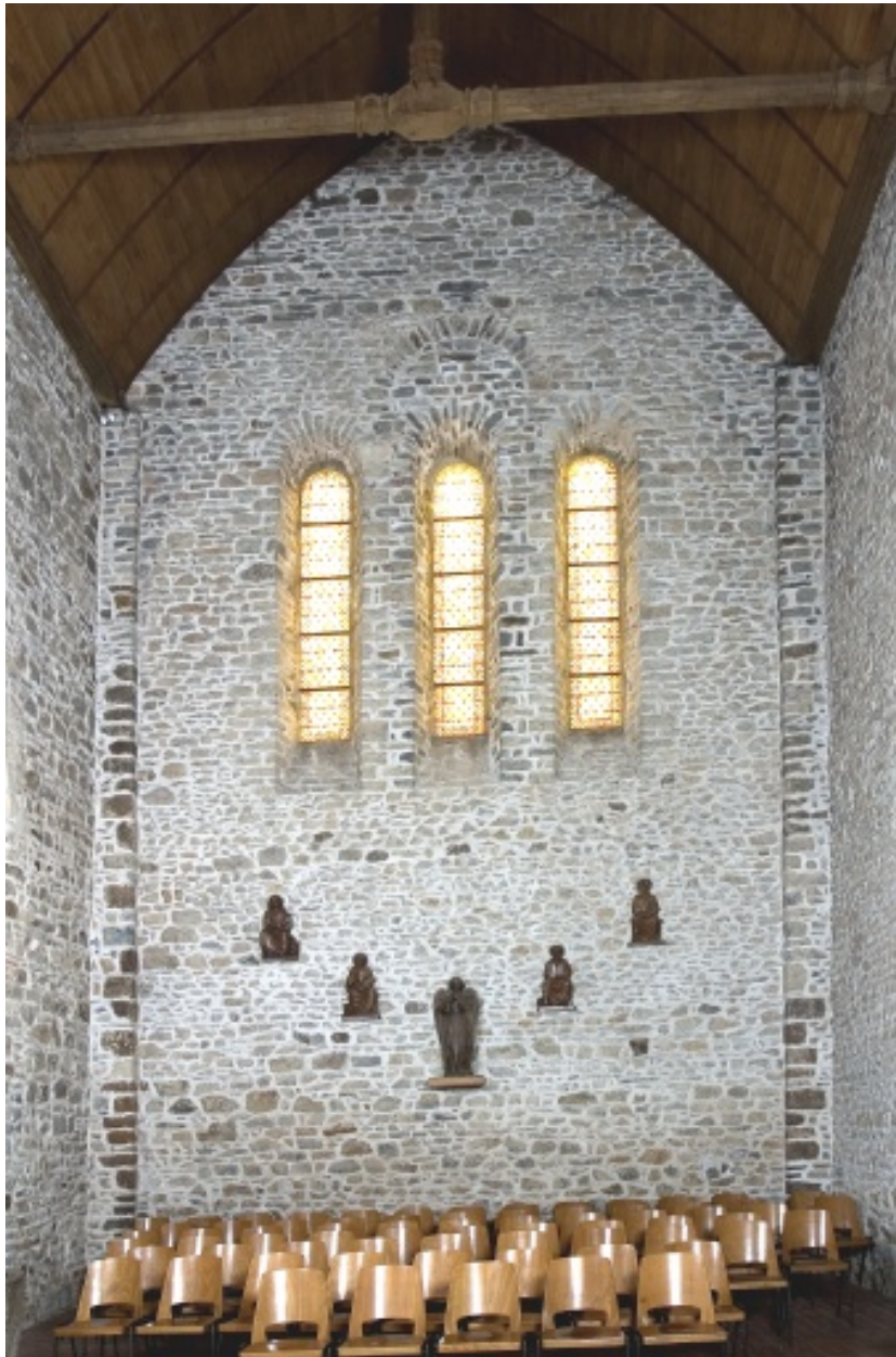
Vue intérieure : le mur sud du bras sud du transept.
