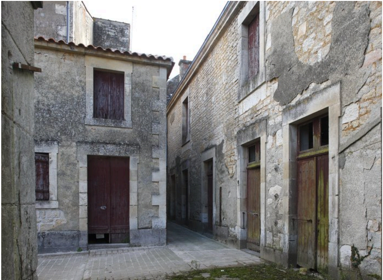
Vue des communs prise de l'ouest.
