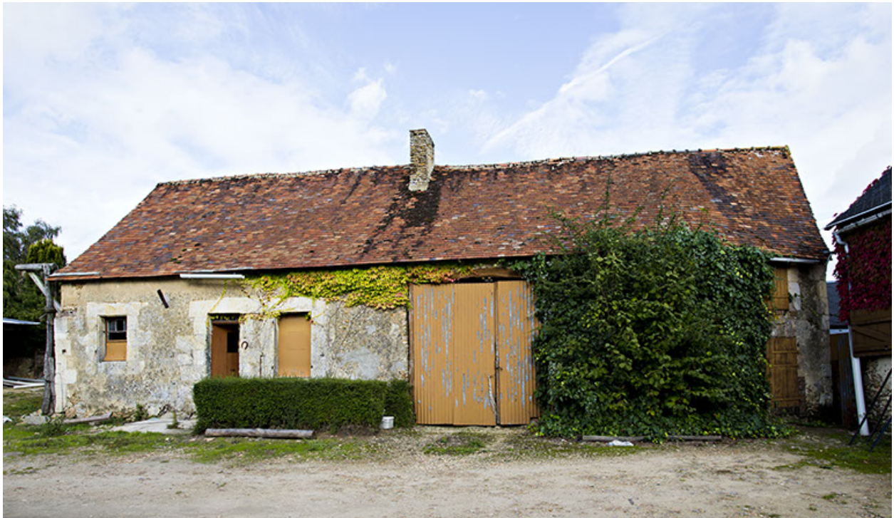
La ferme bloc à terre.
