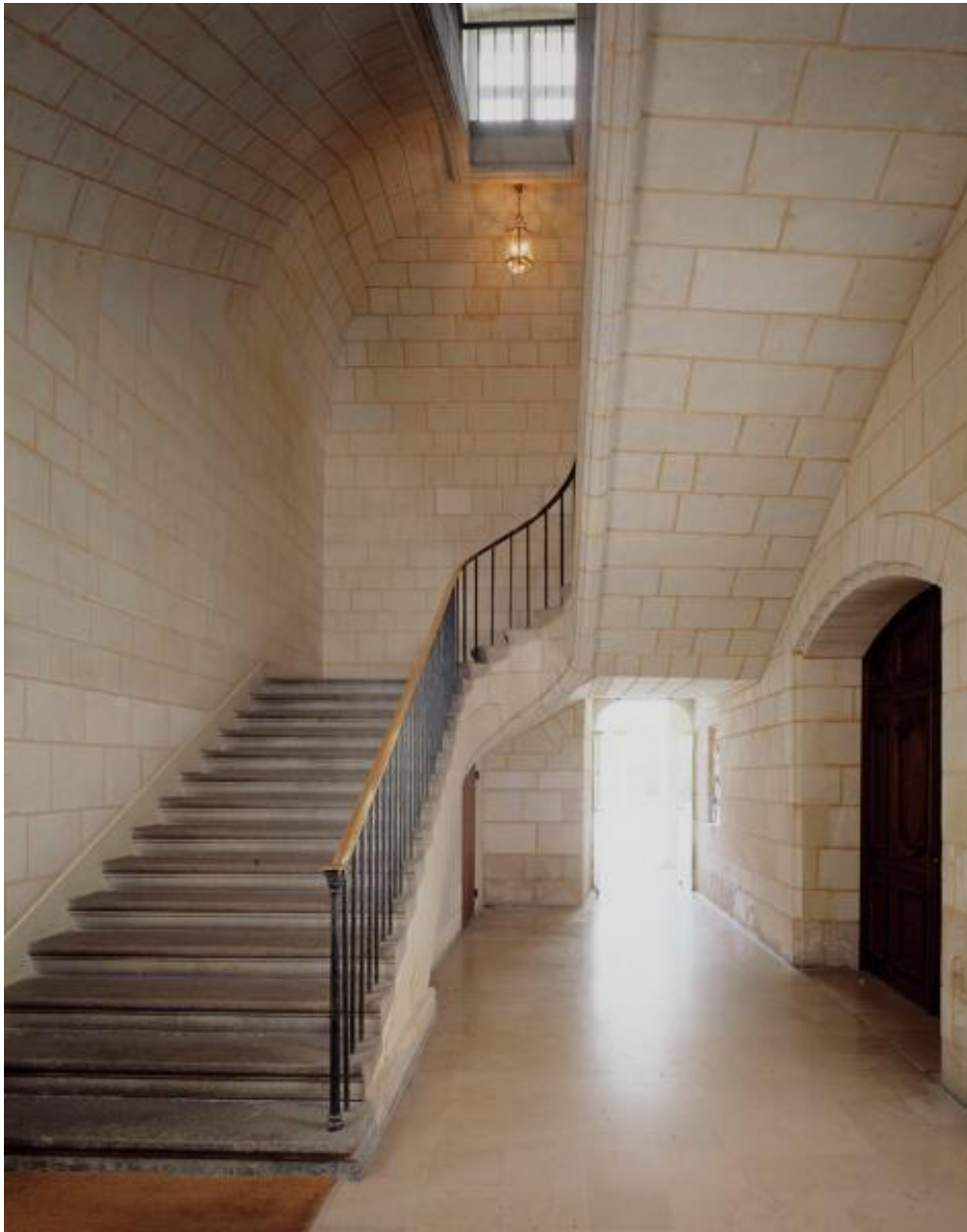
Abbaye, escalier de l'aile orientale : départ de la première volée.
