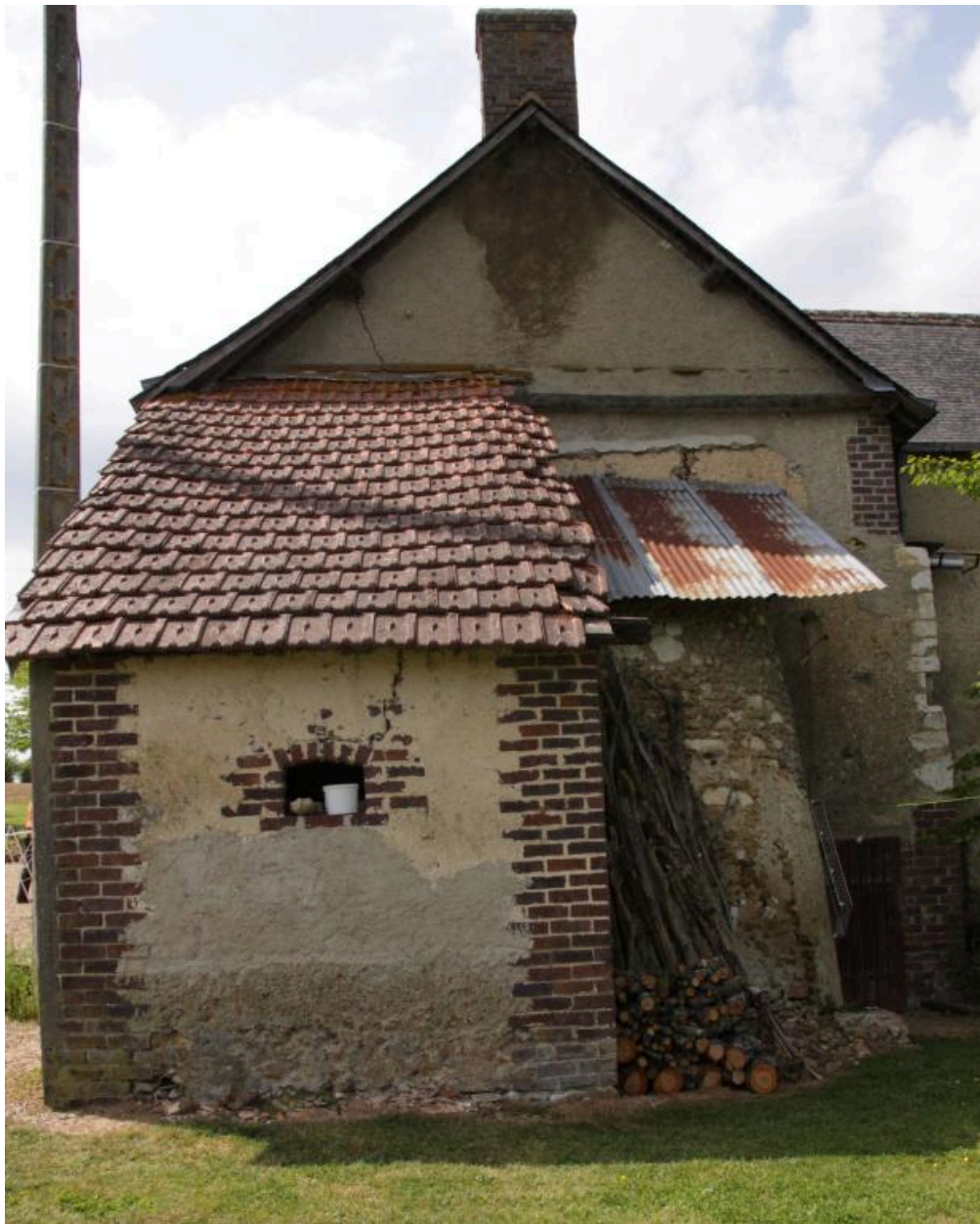
Habitat 1 (côté est) : appentis et four à pain.
