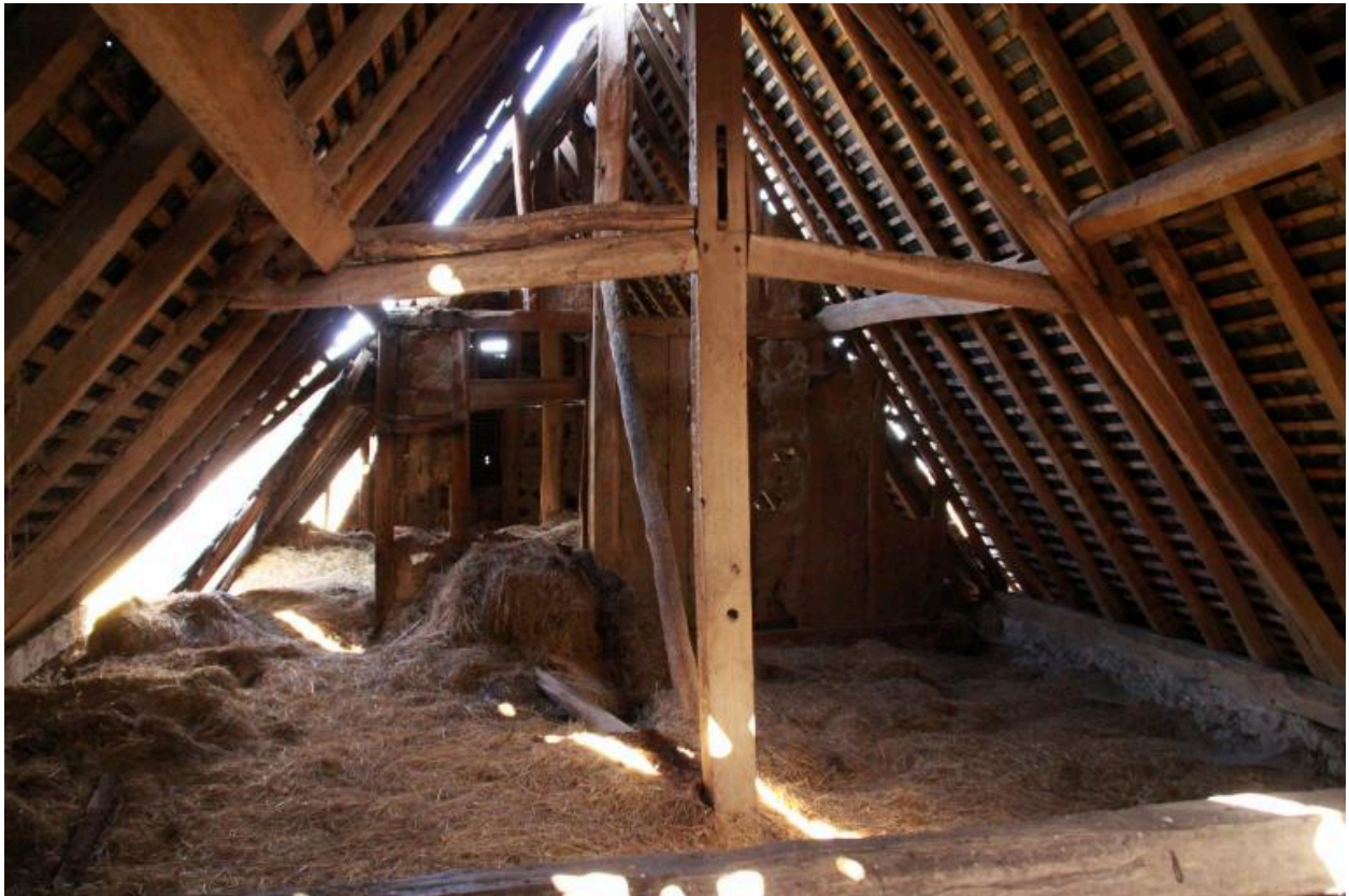
Etable 2 : charpente à pannes (réemploi).
