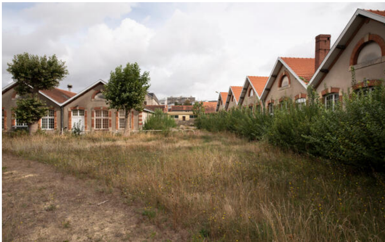
Vue des baraquements au sud et à l'ouest de la caserne.
