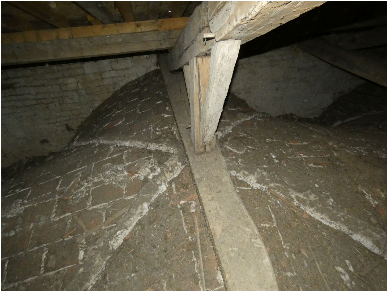
Voûtes du bas-côté nord.
