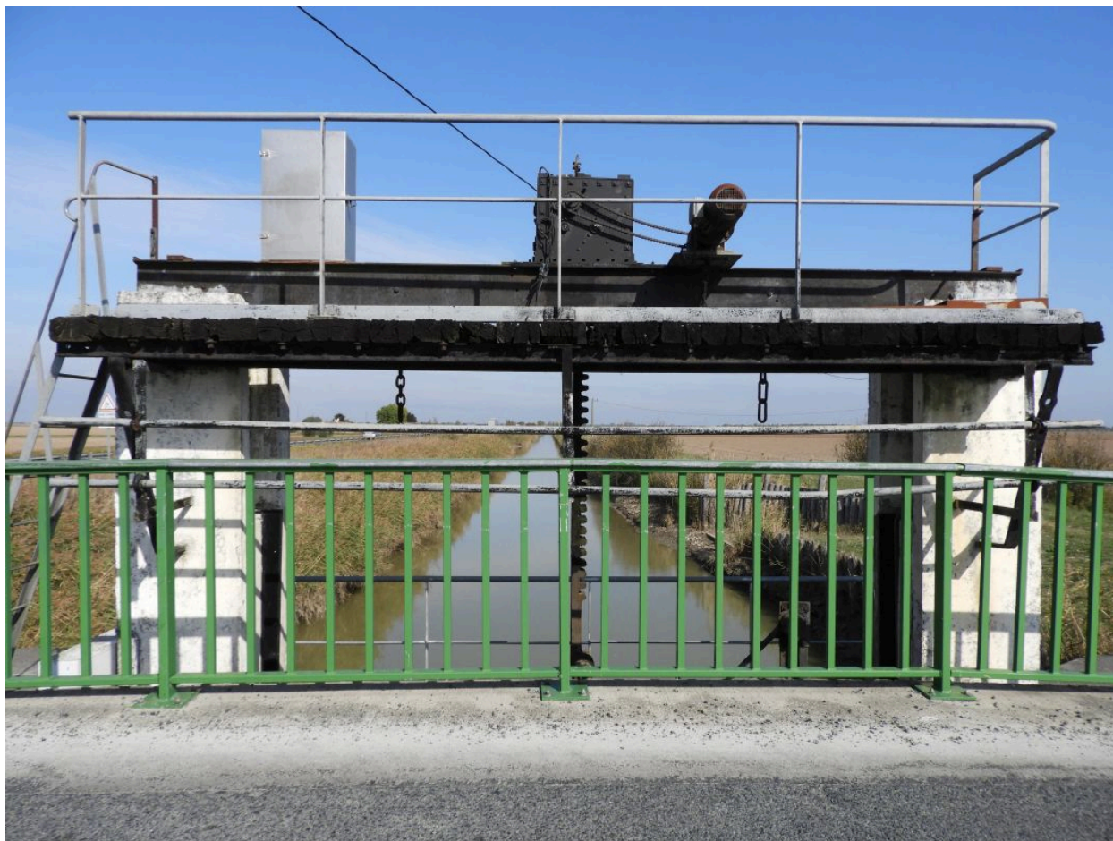
Le portique en métal et béton supportant la vanne verticale.
