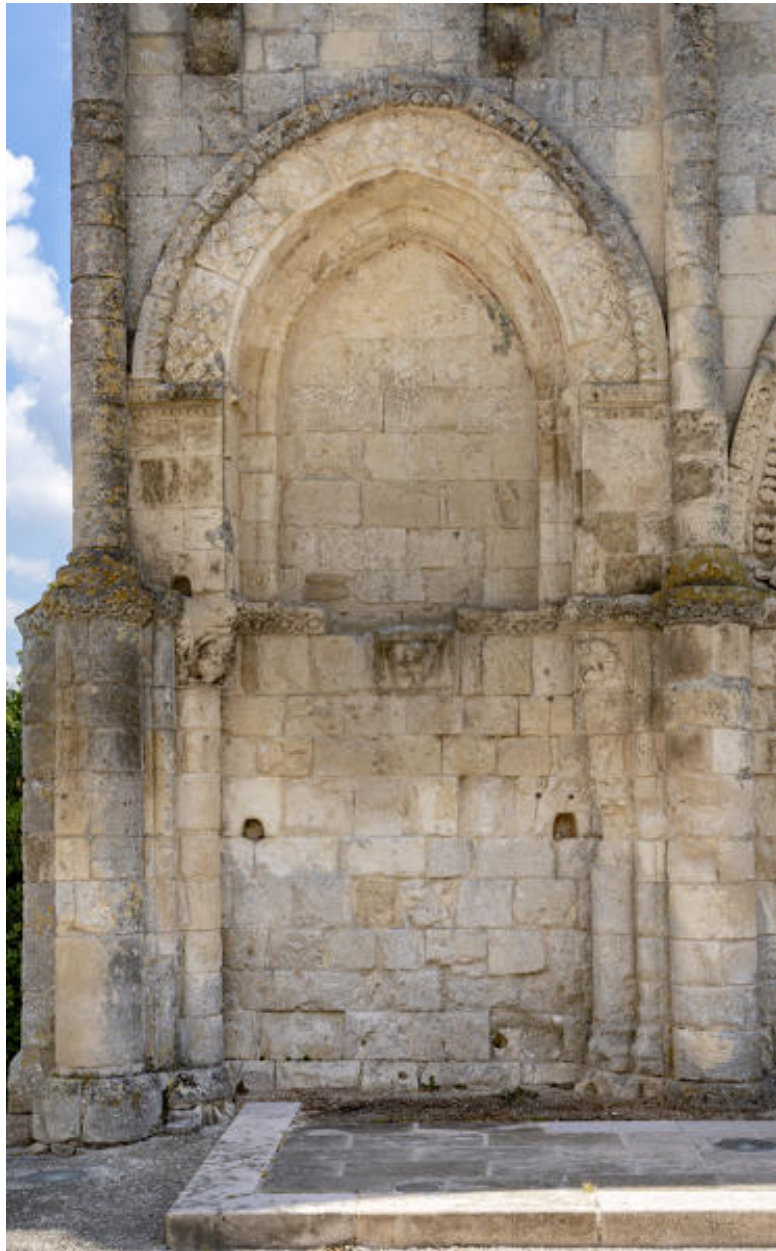
Détail du portail occidental.
