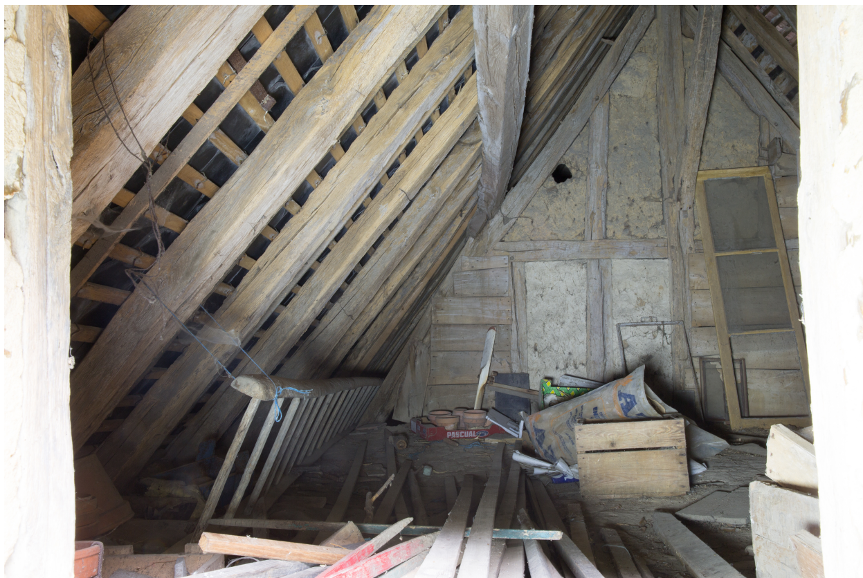
La charpente du logement à pièce unique.
