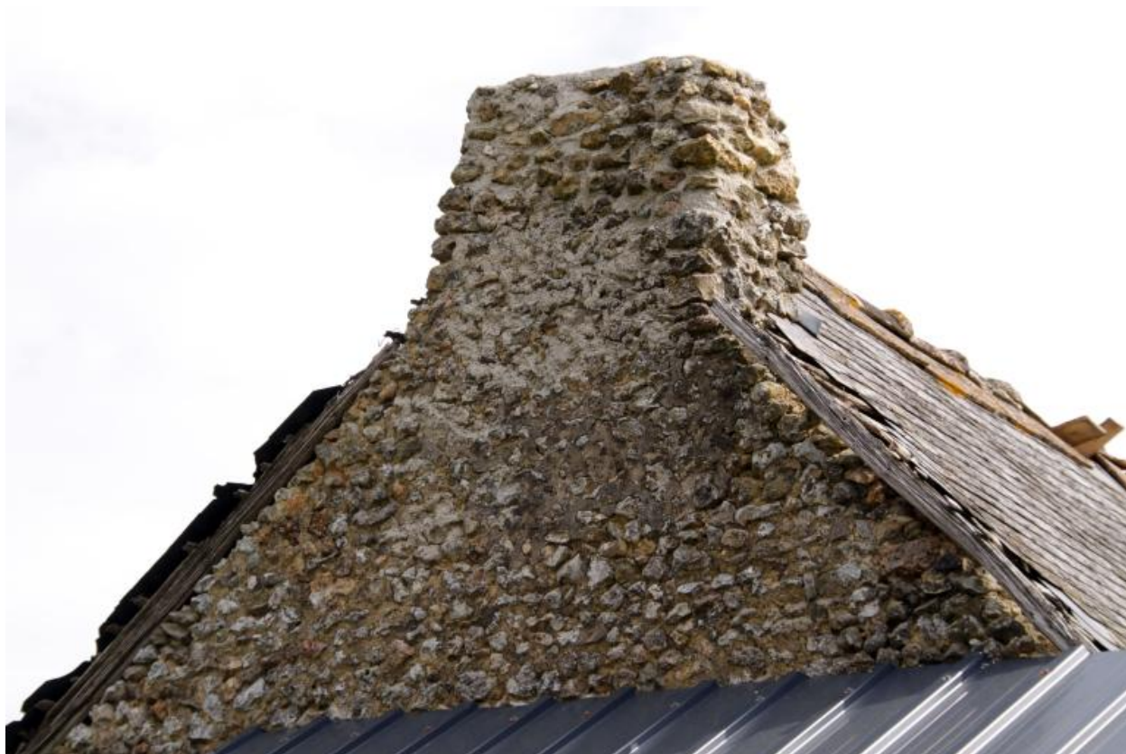
Maison 1 : souche de la cheminée (pignon ouest).
