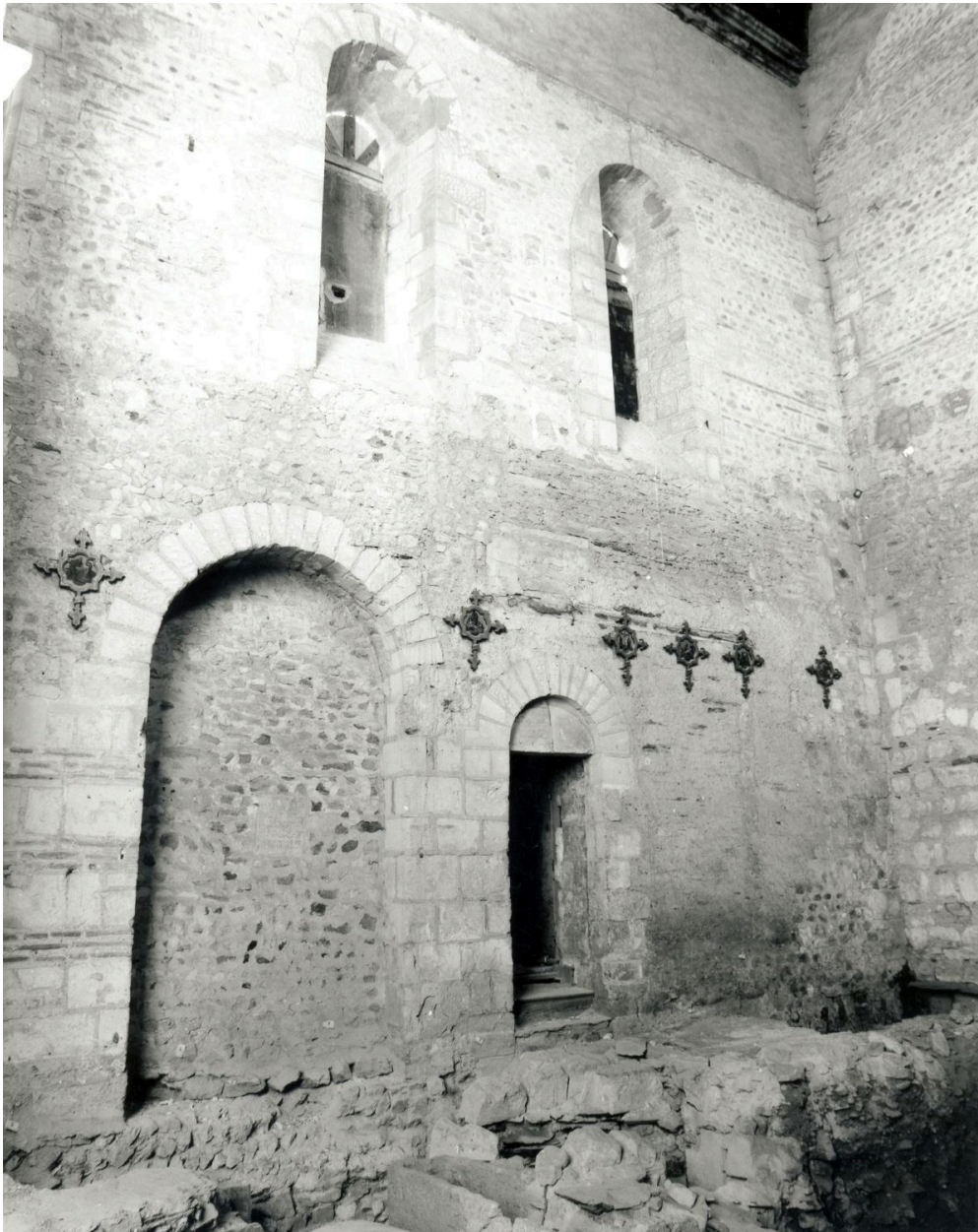
Collégiale Saint-Martin, croisillon sud du transept : élévation est, vue d'ensemble.
