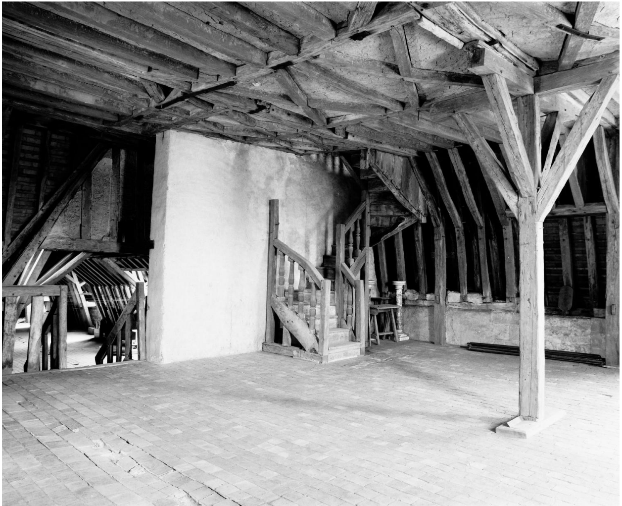
Bâtiment du noviciat, premier étage de comble : vue d'ensemble d'ouest en est. Au fond, comble de l'aîle nord.
