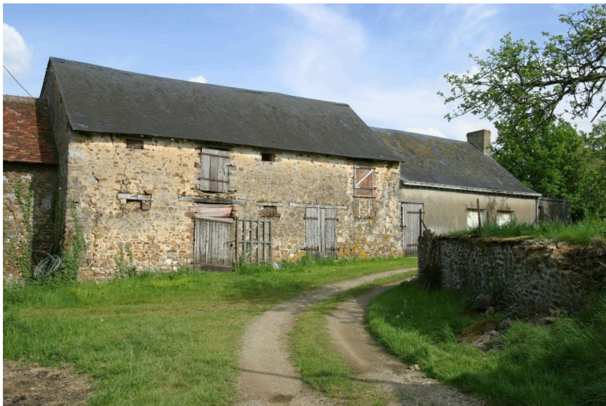
L'étable et le logis 3 vus depuis l'ouest.
