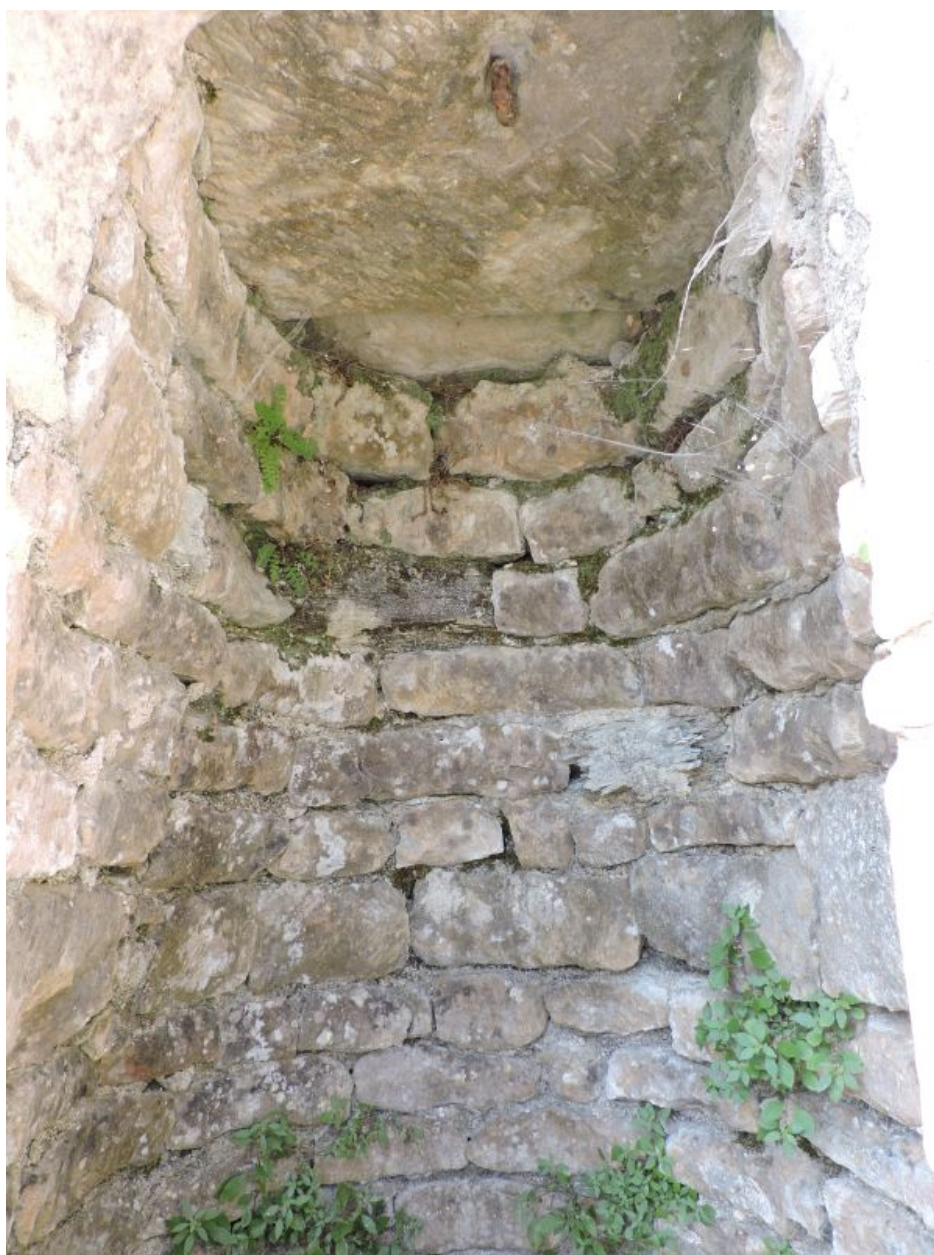
Vue intérieure du puits.
