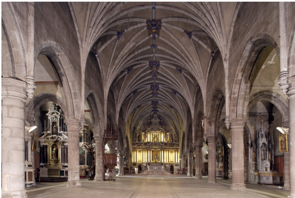
Eglise, nef : vue d'ensemble vers le chœur.
