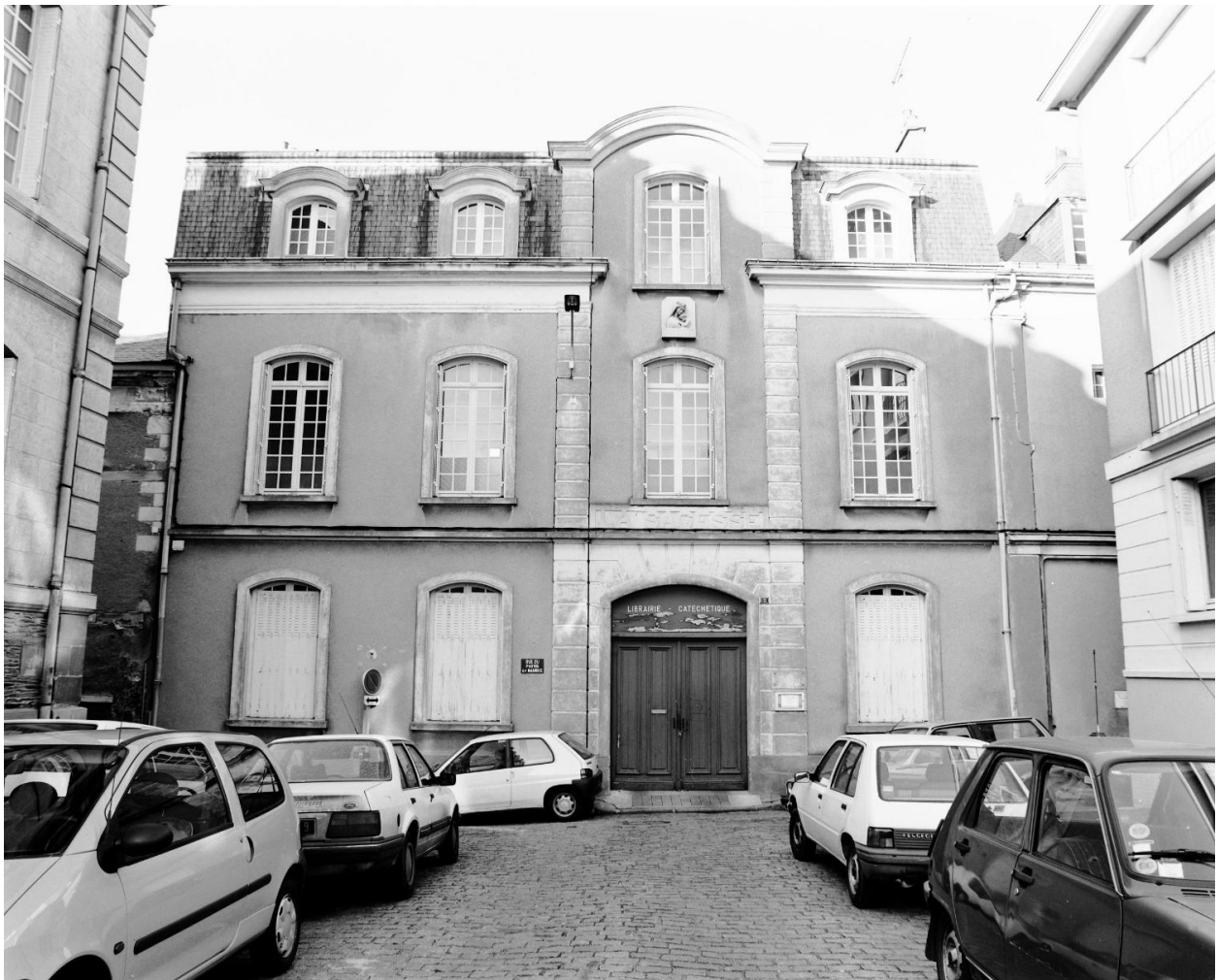
Le corps de bâtiment d'entrée, au n° 7 : élévation sur rue.
